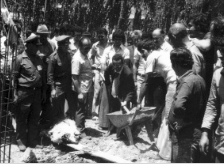
Erdinç Gönenc, bu kez Aydın'da bir Tariş işletmesi inşaatının temeline harç koyarken görülüyor (Ağustos 1978).
